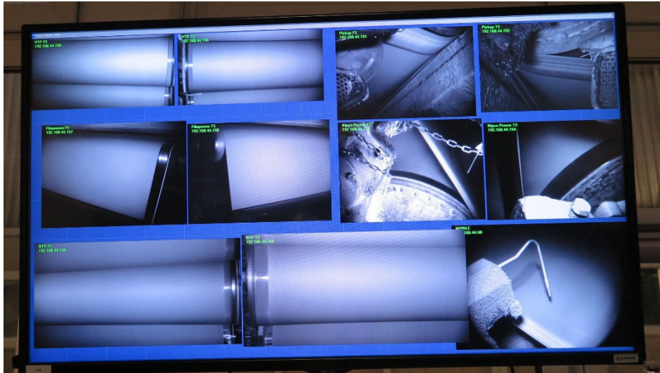
Esempio di monitor operatore cabina conduttore (zona umida)
