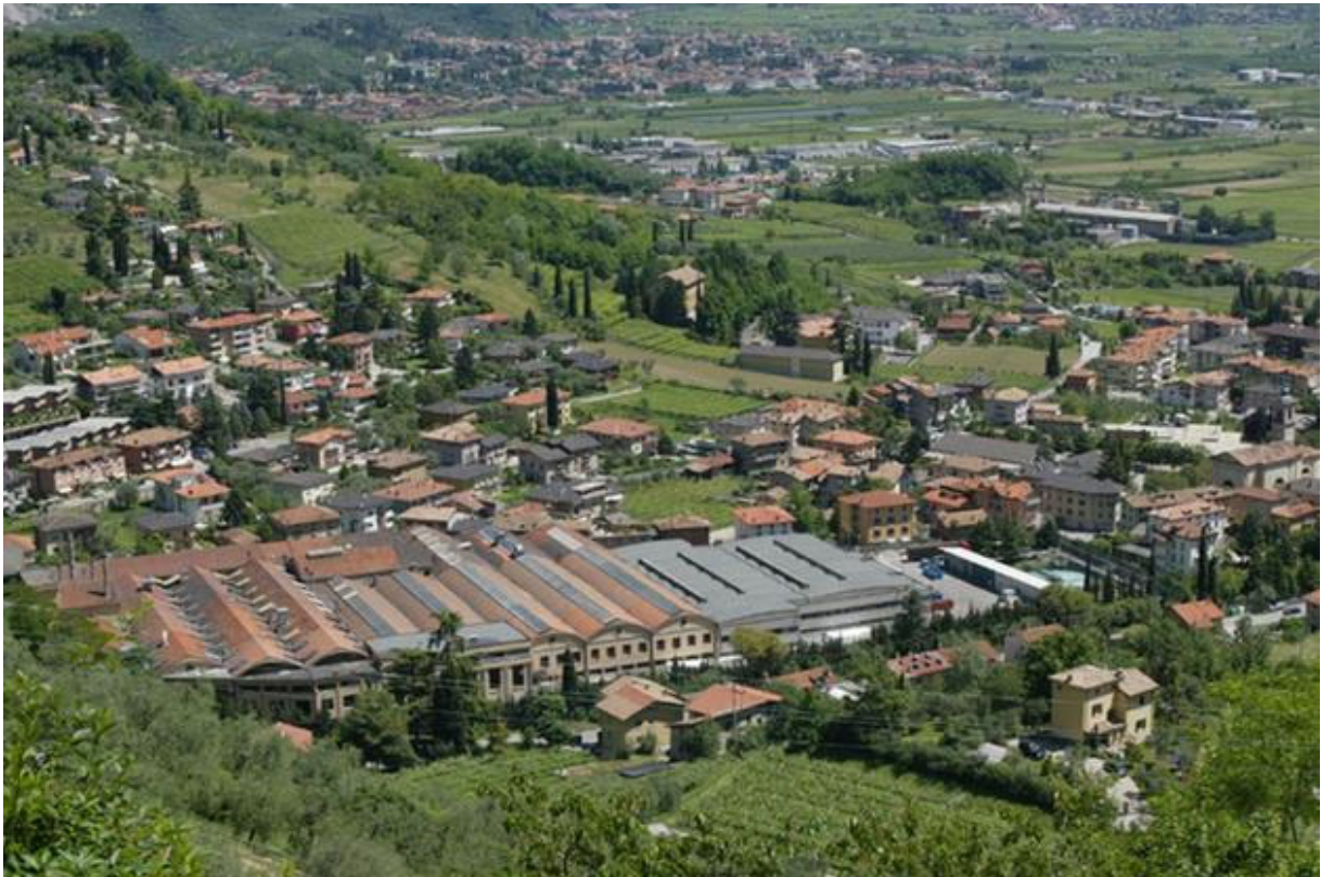
Lo stabilimento di Varone (Riva del Garda – TN)
