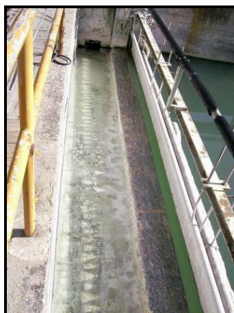
Fig.2.7: Canaletta di uscita.
