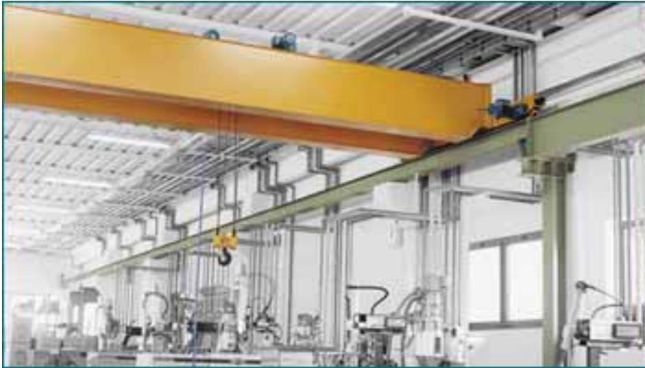
Vanno programmaticamente controllate le funi, l'usura delle ruote, eventuali dilatazioni metalliche e i vari ingranaggi e le zone da lubrificare. Non va poi dimenticata la strumentistica elettrica, con le verifiche alle pulsantiere (di solito aventi prese a più "pin" disinnestabili) e i sensori di "fine corsa", fonti di comando e frenatura di oggetti ingombranti e pericolosi.
