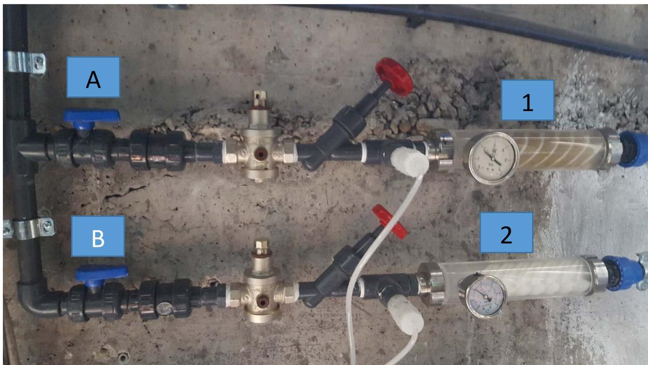
Per permettere all'acqua di miscelarsi ai due prodotti è importante che le valvole A e B siano completamente aperte, per nessun motivo sono concesse aperture intermedie delle stesse.
