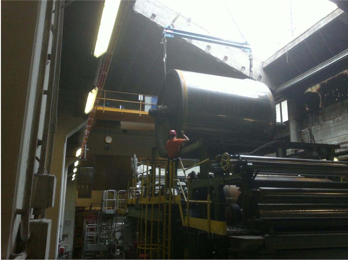
*Monolucido (sostituzione monolucido in ghisa con monolucido in acciaio Tolmezzo 2014)*
